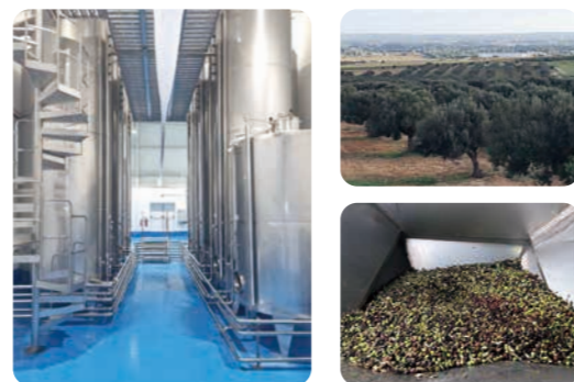
オイルタンク
