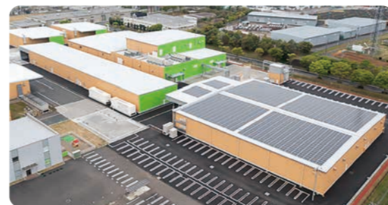
2023年4月に竣工した東日本手指消毒剤製造工場
