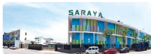
桂林工場(桂林莎羅雅生物技術有限公司) 右の建物が製造棟 左は管理棟
