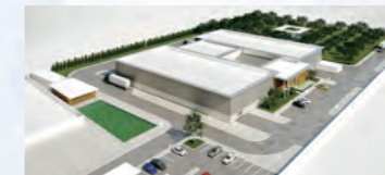
▲建設予定のチュニジア工場
