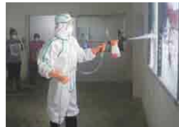
タイのアユタヤ工業団地の被災地で初期化作業を2011年末に実施。工場内の浸水は1.5m程、水が引いた後にはカビが発生し、劣悪な衛生状態だが、施設使用可能な衛生状態への復旧作業を先導させていただいた。お得意様スタッフにサラヤ側から2名が加わり説明と作業にあたった。
