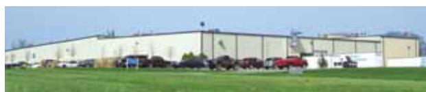
ケンタッキー工場 2006年設立
